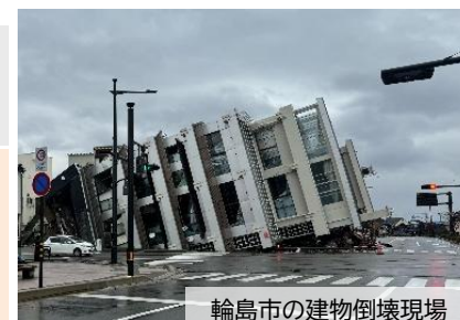
輪島市の建物倒壊現場
