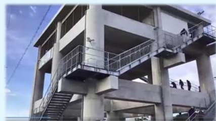
津波避難タワー整備の支援 (志摩市)
