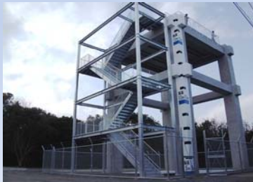
津波避難タワー
