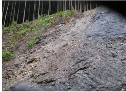
終点部の崖錐と岩盤の層界 流れ盤構造の岩盤上面の崖錐層は 崩落の危険性高い
