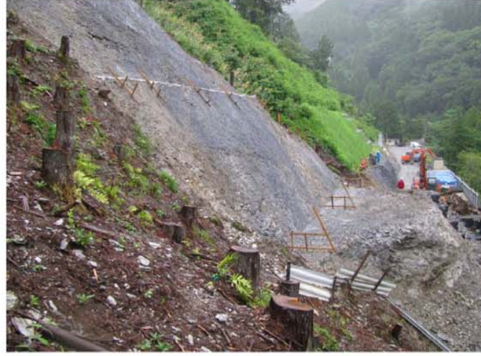
1段目のり面状況 終点側より
