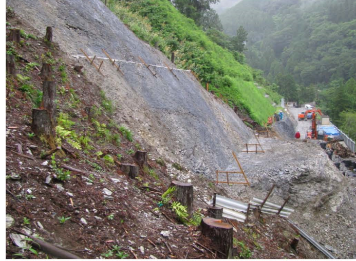
1段目のり面状況 終点側より
