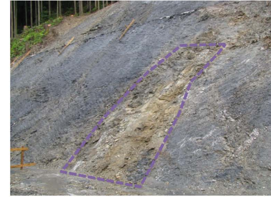
黄褐色の強風化脆弱部 周囲岩より軟質 湧水が確認される
