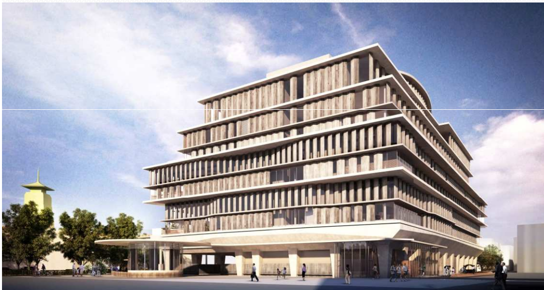
南西側の外観
