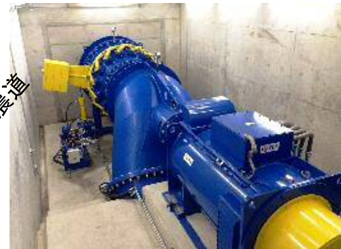
S型チューブラ水車 (富山市 東町・東新町公民館 小水力発電所)
