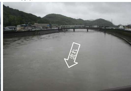
⑧下田川 雄幸(おさじ)橋上流側付近 撮影：H26. 8. 3 16:35
