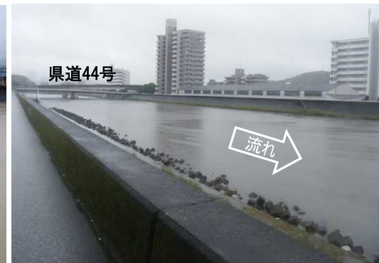
⑦舟入川 県道44号橋梁付近 撮影：H26. 8. 3 15:42
