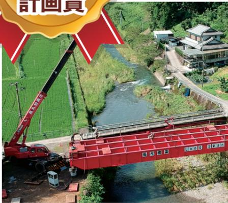
構造を簡易化するとともに、安全性を確保した仮設用の橋。大幅な工期の短縮、工費の削減も実現している。既設の橋が大規模災害や老朽化によって崩壊し、緊急仮設橋を設置する場合には必要とされる急速性、安全性、経済性を兼ね備えている。
