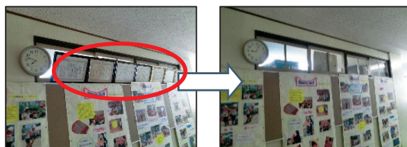
【落下の可能性のある廊下の表彰状の額を撤去】
