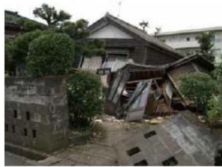
【全壊】一見して住家全部が倒壊
