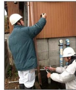
(住宅の傾斜の計測)
