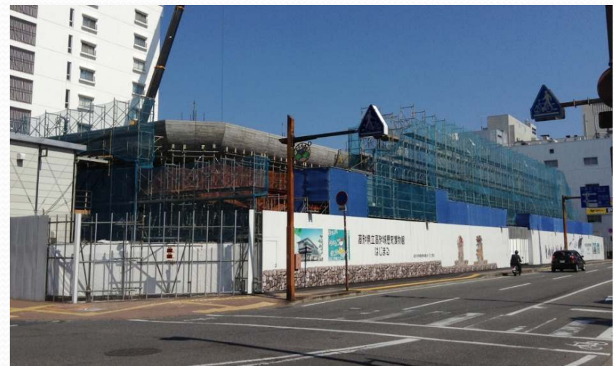
・現在の施工状況(追手門から)
