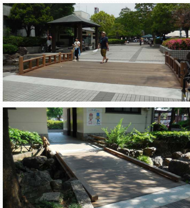
・改修された通路橋
