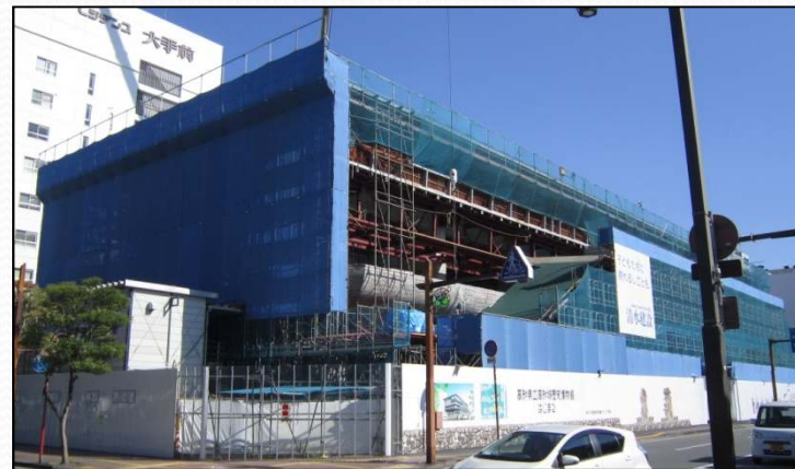
・現在の工事の状況
