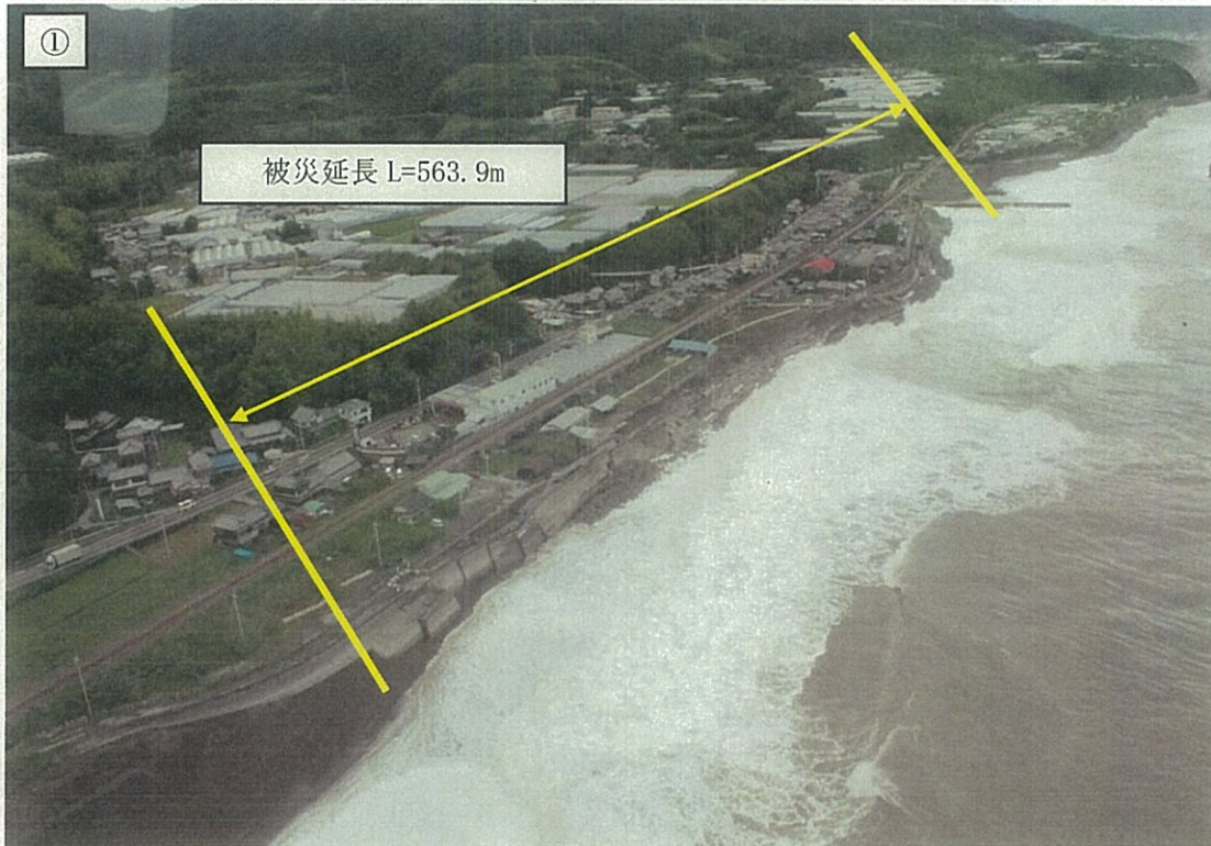
平成 23 年 7 月台風 6 号で被災した穴内漁港海岸
