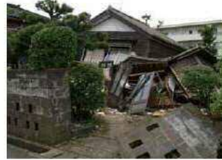
【全壊】一見して住家全部が倒壊
