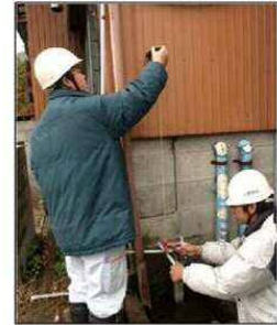
(住宅の傾斜の計測)
