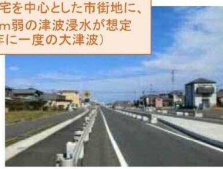
沿道は低層住宅が中心
