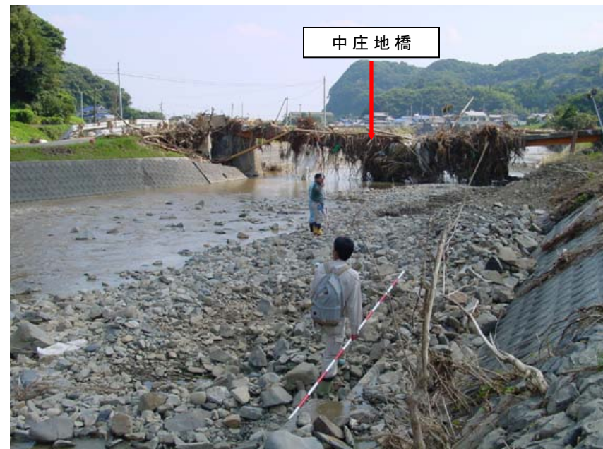
貝ノ川地区中庄地橋付近の被災状況 (平成13年10月撮影)
