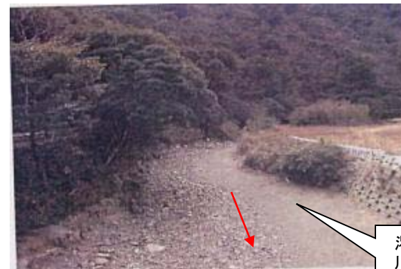
中小路頭首工上流部(H16. 2月撮影)
