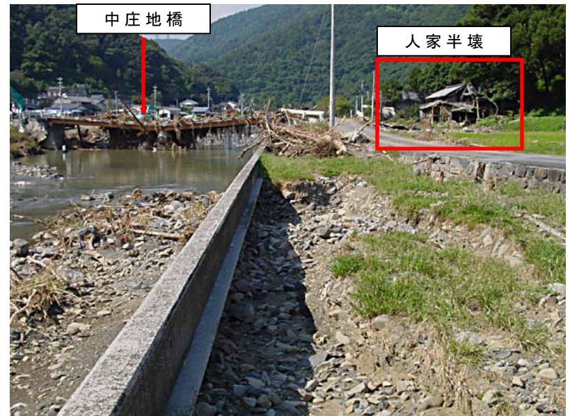
貝ノ川地区中庄地橋下流部の被災状況 (平成13年10月撮影)
