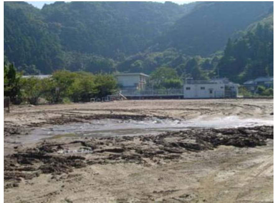
貝ノ川地区貝の川小学校の被災状況 (平成13年10月撮影)
