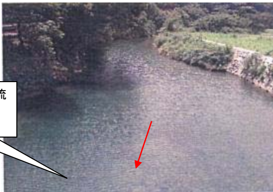
中小路頭首工上流部(H15. 7月撮影)
