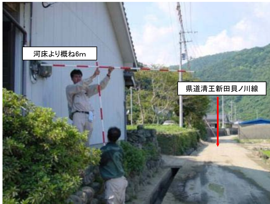
貝ノ川地区右岸堤内地の被災状況 (平成13年10月撮影)
