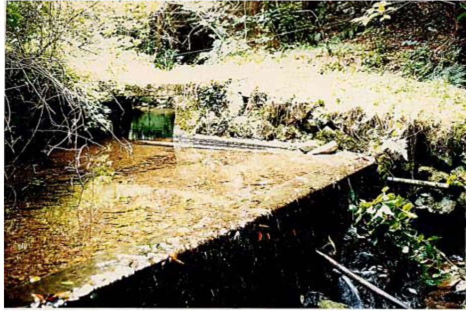
取水源状況 (平成13年6月撮影、春遠簡易水道)
