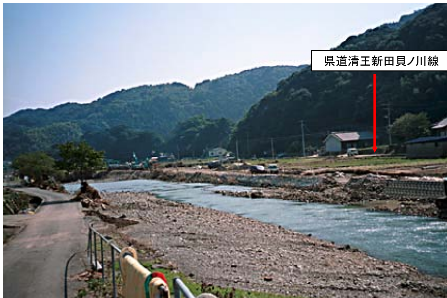
貝ノ川地区中庄地橋上流部の被災状況 (平成13年10月撮影)
