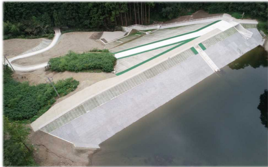
県営ため池整備事業(南国市中部1期地区:定林寺上池)
