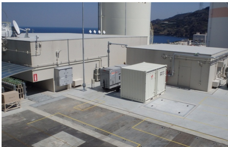
追加設置した緊急時対策所（左側の建物）
