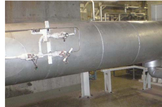
配管の耐震補強工事
