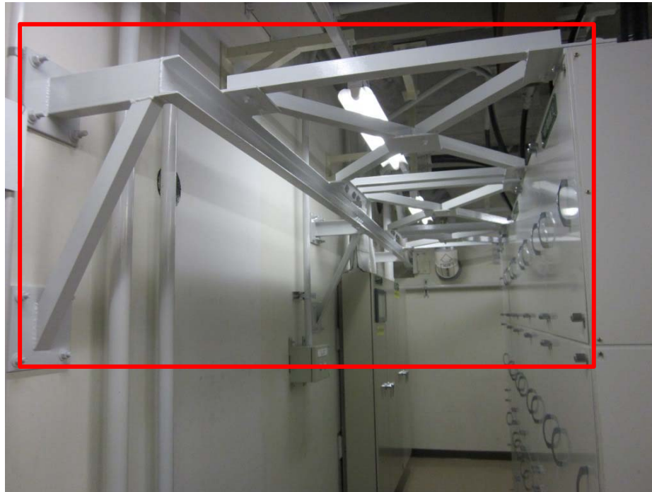
直流電源装置（充電器盤・ドロツパ盤）の 耐震補強工事
