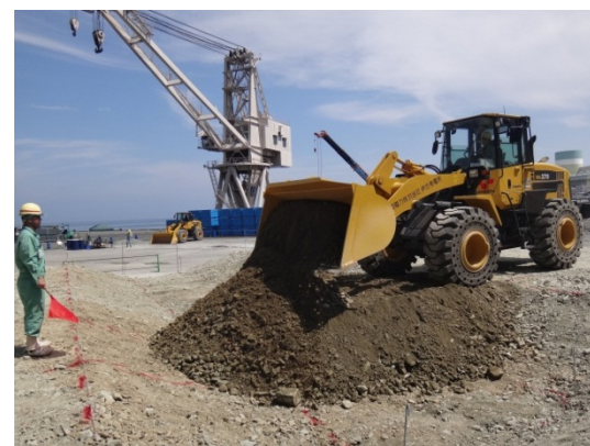
ホイールローダでの陥没箇所修復訓練
