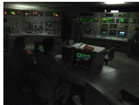
シミュレーター訓練（全交流電源喪失）
