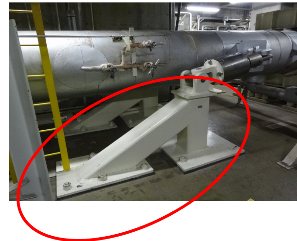
配管の耐震補強工事
