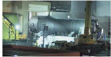
2号機蒸気発生器取替工事
