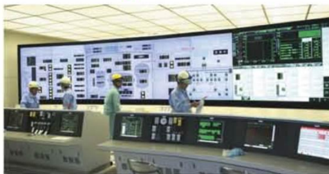
1,2号機中央制御盤等取替工事
