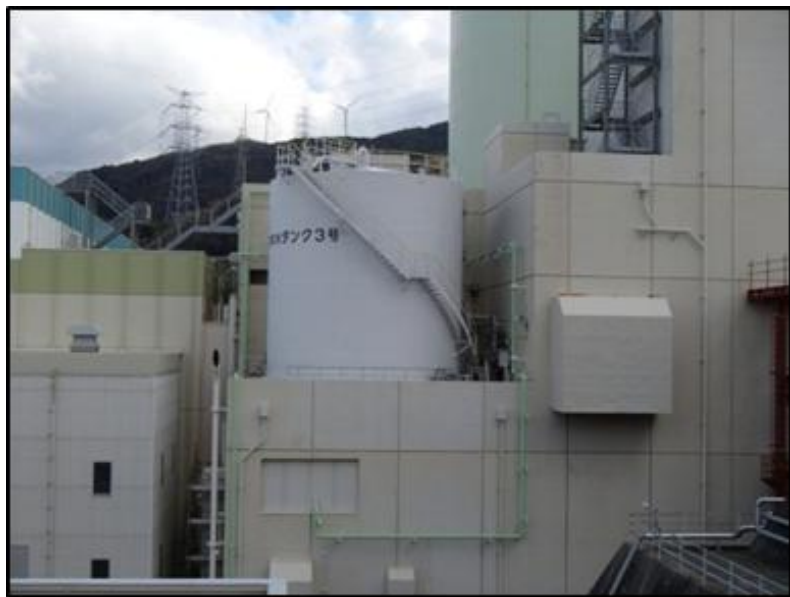
【防護対策実施前】
