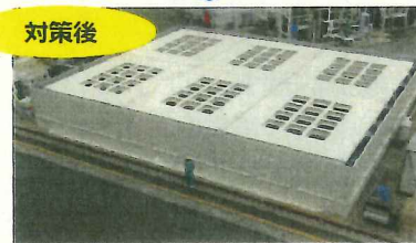
竜巻防護対策設備 (例：海水ピットポンプ室防護壁)
