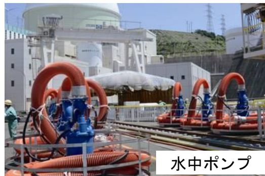
図②-1-5 浸水対策設備配備場所
