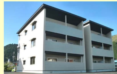
用途 : 集合住宅 CLT部分 : 床、壁、屋根、まぐさ 所在地 : 岡山県真庭市 写真提供 : 銘建工業(株)
