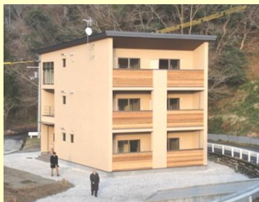
用途 : 集合住宅 CLT部分 : 床、壁、天井 所在地 : 高知県長岡郡大豊町
