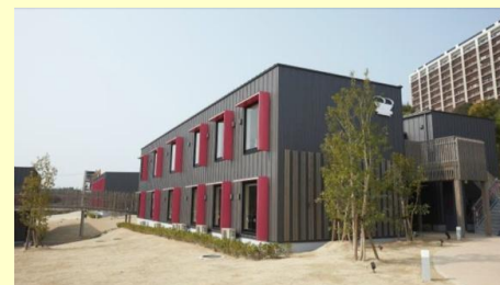
用途 : ホテル CLT部分 : 床、壁 所在地 : 長崎県佐世保市 写真提供 : ハウステンボス(株)
