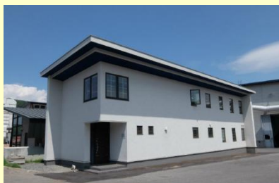
用途 : セミナーハウス CLT部分 : 壁、2階床、天井 所在地 : 北海道北見市 写真撮影 : 協同組合オホーツクウッドピア
