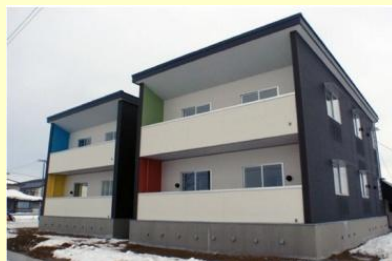
用途 : 集合住宅 CLT部分 : 床、壁、天井 所在地 : 福島県河沼郡湯川村 写真撮影 : 会津土建(株)
