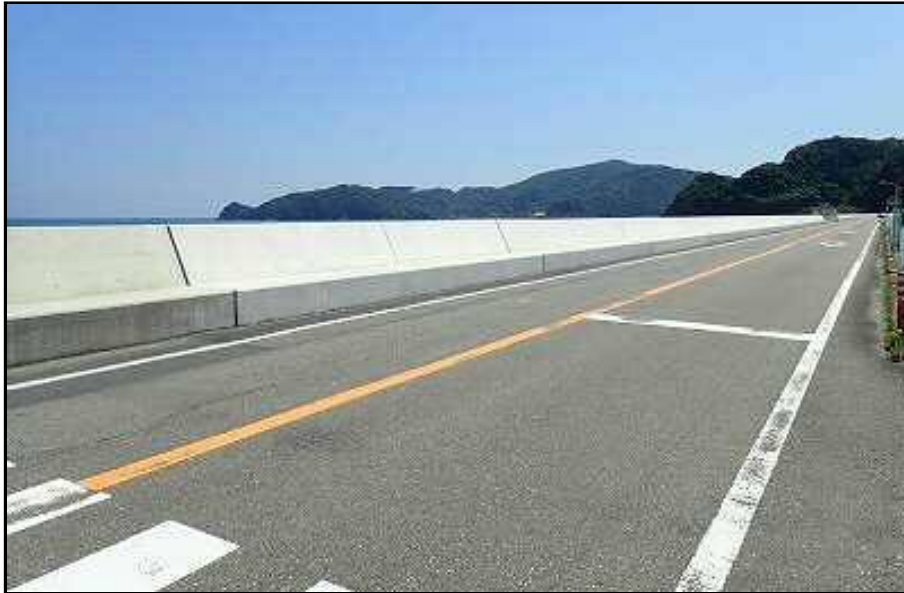
漁高潮第1-3-2号 宇佐漁港海岸高潮対策工事
