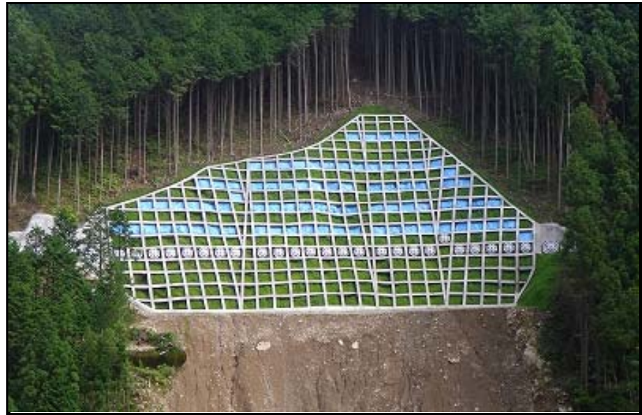
災関治山第911号 小日浦災害関連緊急治山工事
