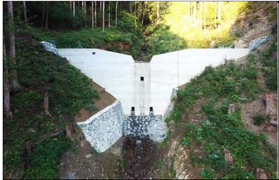
復旧第9号 弘瀬復旧治山工事
