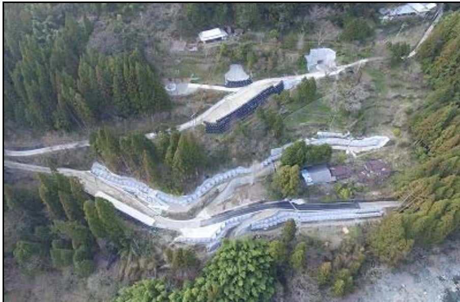
災関地すべり第903-1号 西梶ヶ内災害関連緊急地すべり防止工事
