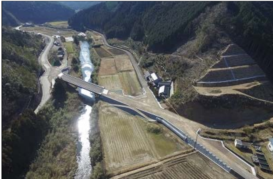
道交地防安(改築)第101-014-8号 県道窪川船戸線防災・安全交付金工事
