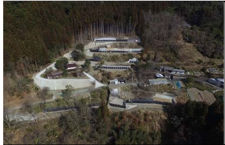
災関地すべり第902号 寺内災害関連緊急地すべり防止工事
