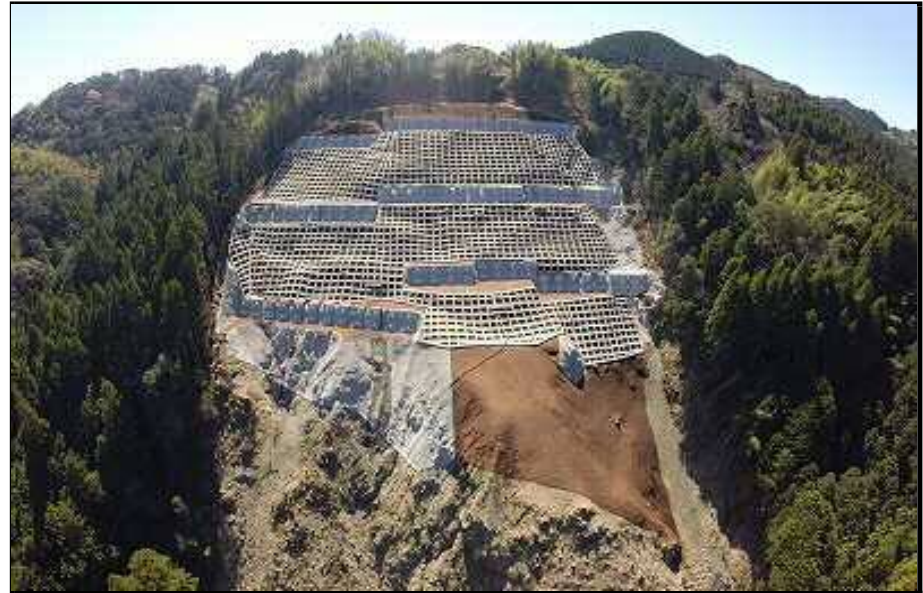
緊急地すべり第1-1-8号 鏡的淵地区災害関連緊急地すべり対策工事
