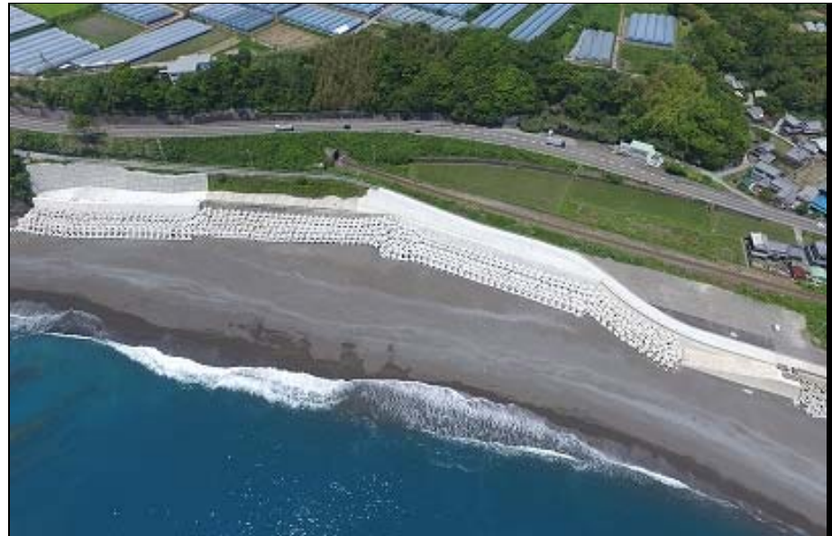
26災第1320-6号 県道高知安芸自転車道線道路災害復旧工事
