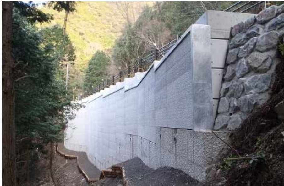
道交国防安(特改)第114-004-05号 国道439号防災・安全交付金工事
