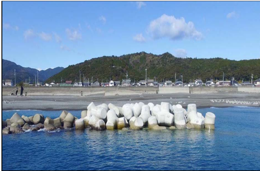
河高潮第1-1号 野根海岸高潮対策工事
