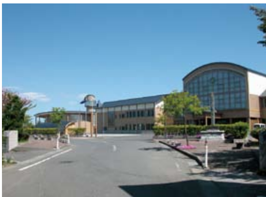
むつ市川内庁舎および海と森ふれあい体験館 (青森県) 詳細参照P17 別棟解釈により木造とした建築例
