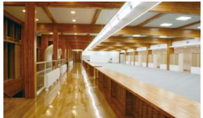
足寄町役場庁舎(北海道) 詳細参照P3 燃えしろ設計による建築例
