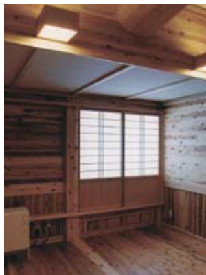
有峰ハウス(富山県) 詳細参照P19 宿泊室の天井仕上げ材を準不燃材料とすることで、壁仕上げ材に木材を採用した建築例
