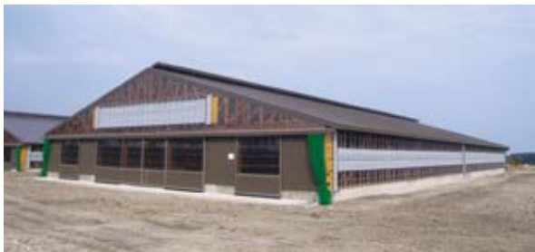
オホーツクはまなす牧場育成牛舎 延べ面積1,774.46m 2 だが、畜舎の用途なので防火壁(法26条3項)と小屋裏隔壁(令114条3項3号)を設けていない。
