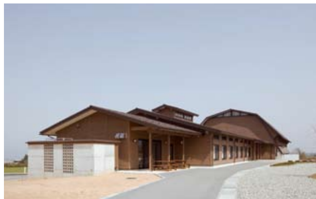
魚津もくもくホール(富山県) 詳細参照P15 別棟解釈により木造とした建築例
