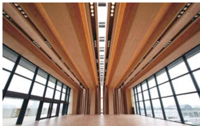
東京木材問屋協同組合 新・木材会館(東京都) 耐火性能検証法による建築例
