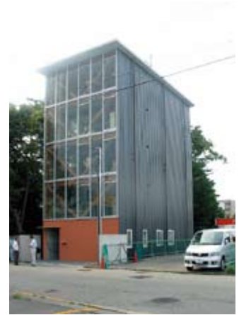
Mビル(石川県金沢市) 準防火地域に建つ5階建て木造耐火建築物(1階RC造、2~5階・木質ハイブリッド耐火構造)
