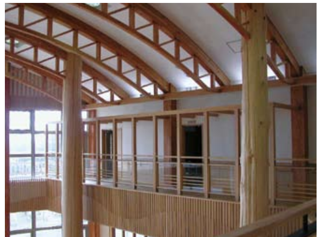
むつ市川内庁舎(青森県：軒高11.98m 最高高さ 14.48m) 1時間準耐火建築物とした建築例
