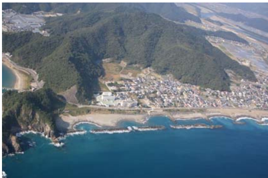
〔侵食対策事業の状況（新居海岸）〕
