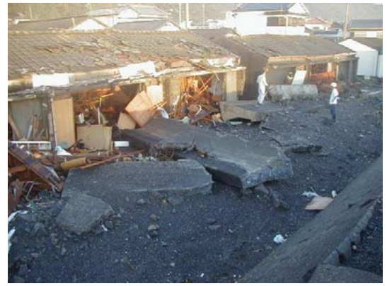
〔菜生海岸被災状況（室戸市）〕
