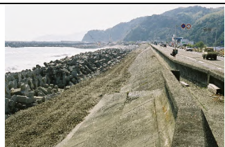
②護岸状況
