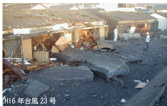
〔菜生海岸被災状況（室戸市）〕
