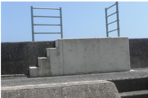
〔陸閘常時閉鎖 事例〕
