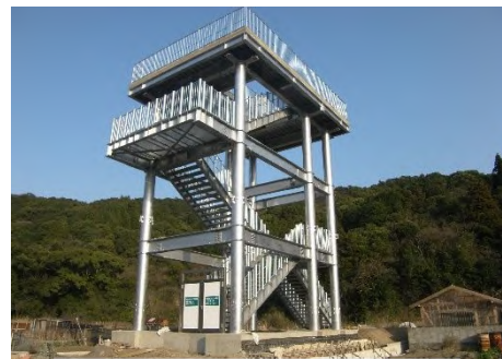
〔津波避難タワー（四万十町）〕
