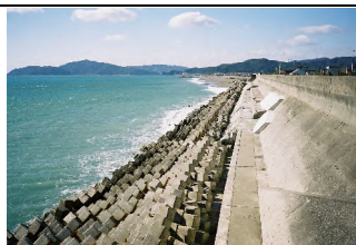
③護岸状況
