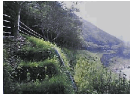
終点側より(施工後)
