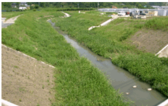
工事完成から5ヵ月後の状況
