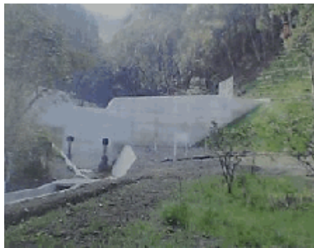
全景(施工後) 下流より
