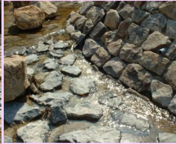
掘削により転石が出てきたので天然護岸として流路内に残しました。流路の幅は横になった転石の先端当たりで標準よりやや狭いですが、護岸を引いてますので通水断面は確保できています。
