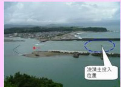
黒の破線部分は大きなうねりとなり、砂州がない為、波が直接航路に影響している。
