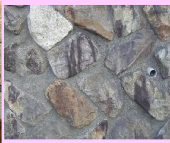
通常は護岸工であれば谷積みが標準ですが、この現場では施工段階で、視覚的に小川の連続性をイメージして、布積みにしました。コンクリートは深目地に仕上げています。
