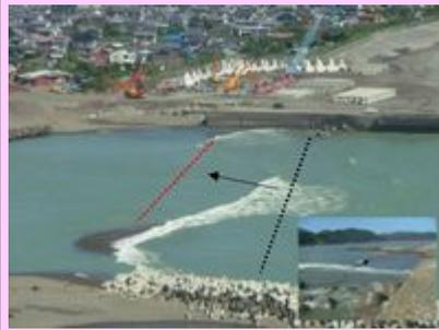
9 / 7の突堤前面の砂は消波堤位置まで押されている。全体的には50m程度上流へ移動している。導流堤位置には水面上まで砂洲が形成され、碎波状況より推測すると、残りの水面下も砂洲の形成が想定される。
