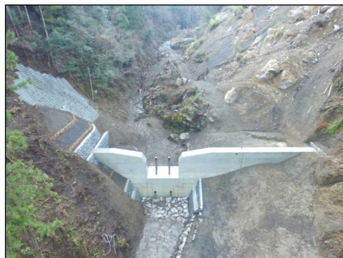
施工後（谷止工、流木除去）
