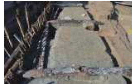
溝の石積みの基礎構造
