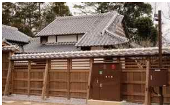
整備した防災設備と塀、奥に主屋
