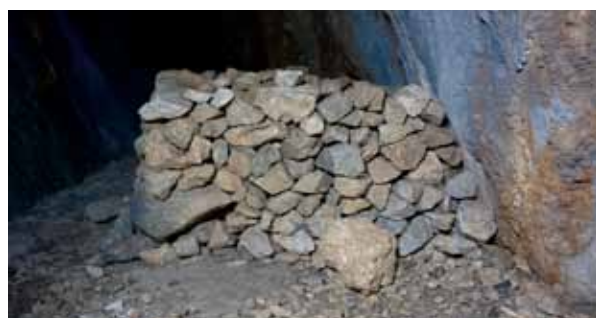
爆風避け石積み南面（南より）
