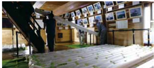
漆を塗り終わった高欄部材の搬入(天守4階)
