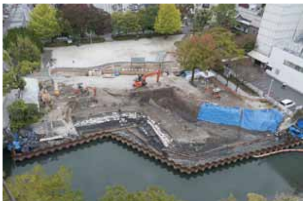
新堀川護岸発掘調査 (令和3年2月) 撮影
