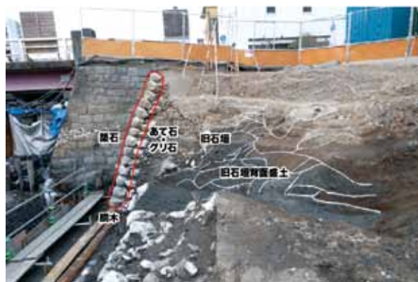
現護岸石垣と江戸時代の護岸の背面構造
