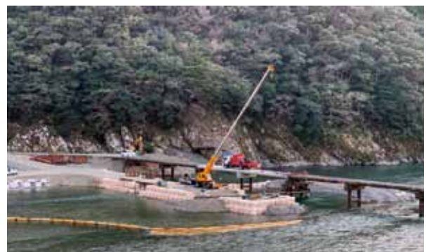
岩間大橋の修繕
