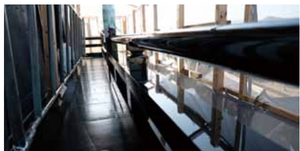
高欄の組立完了
