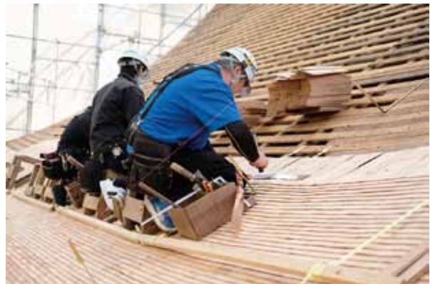
本殿屋根の柿葺き替えの様子
