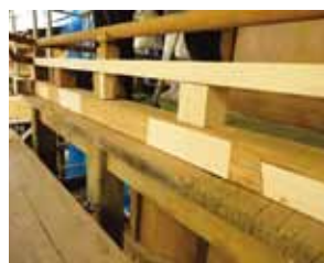
本殿高欄の補修
