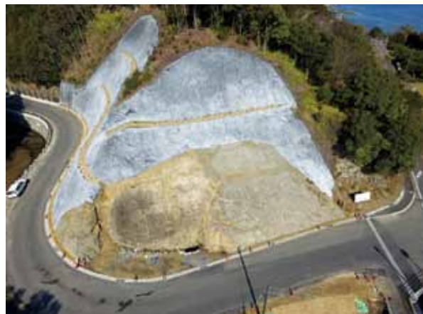
道路整備後の枕状溶岩の全景
