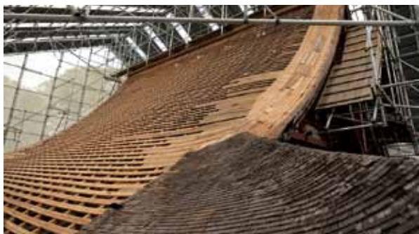
本殿屋根の解体(令和2年6月)
