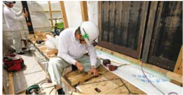
縁板補修の様子
