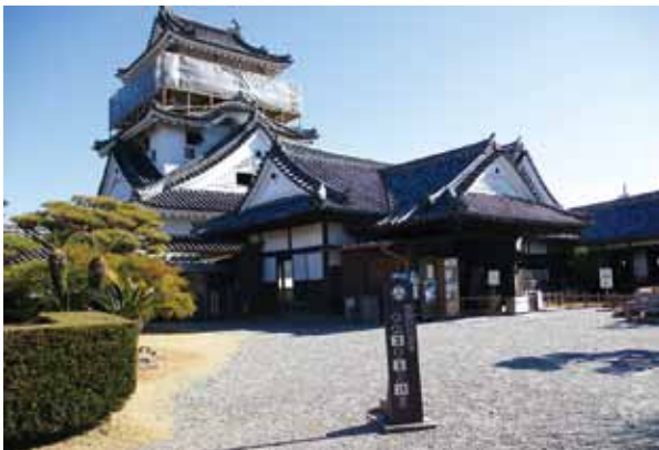
天守高欄保存修理中の高知城天守
