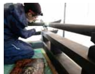
本殿高欄の漆塗りの様子
