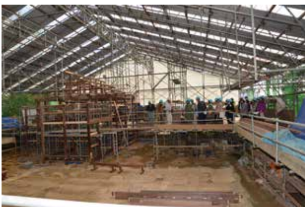
現場見学会・保存修理中の主屋
