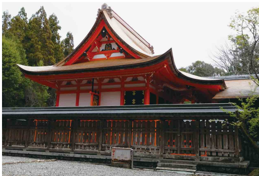
土佐神社本殿(修理後)
