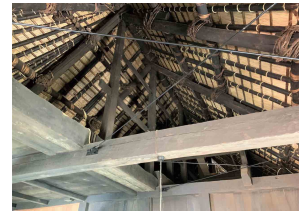
鉄筋ブレース補強
