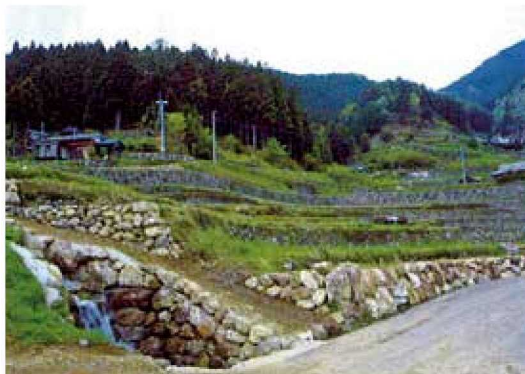
棚田の石垣を保全した例
