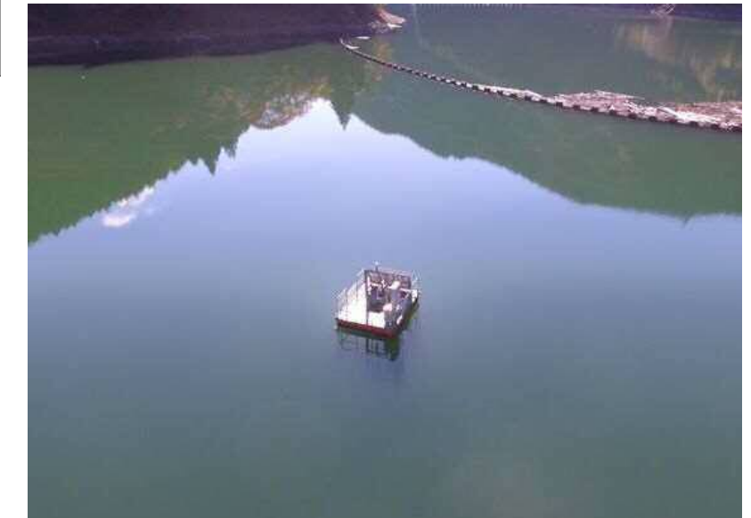
▲自動濁度計 全景
