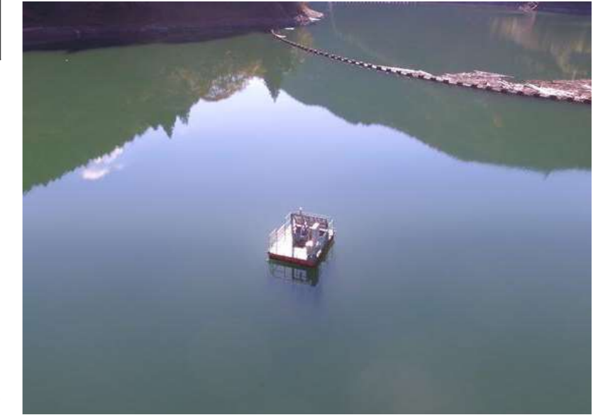
▲自動濁度計 全景
