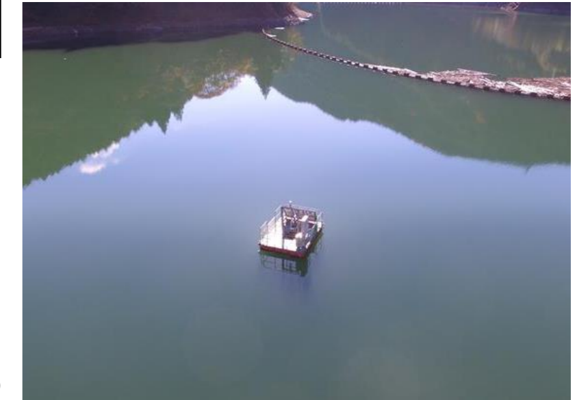
▲自動濁度計 全景
