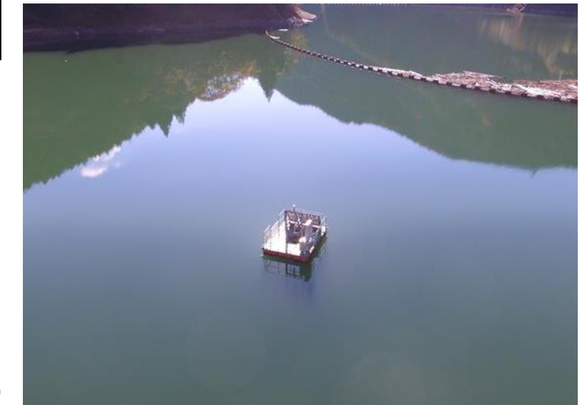
▲自動濁度計 全景
