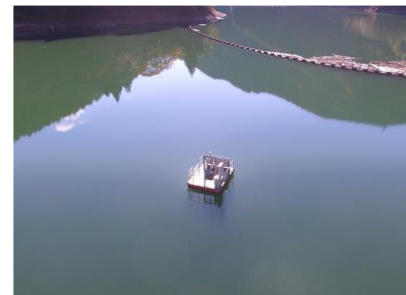
▲自動濁度計 全景
