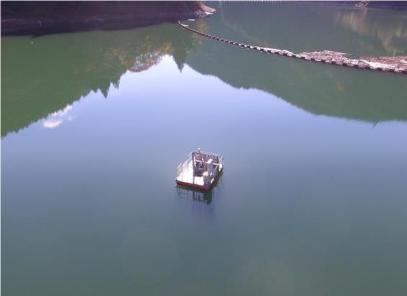
▲自動濁度計 全景
