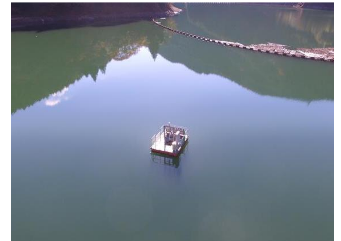
▲自動濁度計 全景
