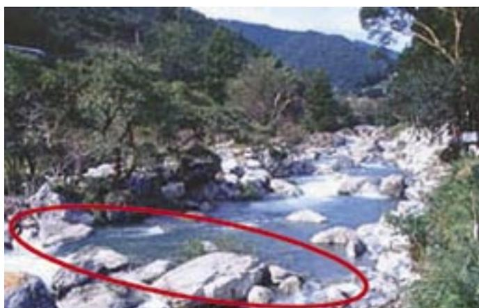
写真 - 9 水生植物に配慮した巨石の落差工の事例（鏡村）
