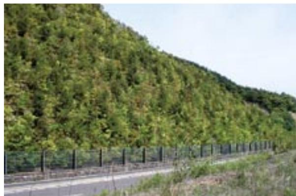
写真 - 18 在来種による緑化を図った「ポット苗工法」の事例（中村市）
