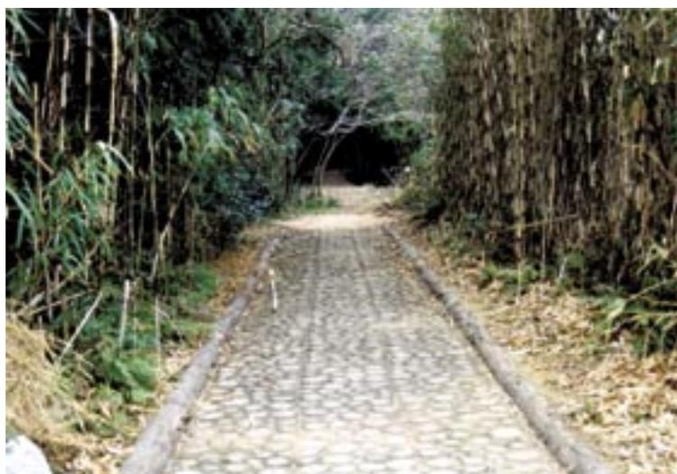
写真 - 19 路面に間伐材を使用し環境に配慮したウォーキングトレイルの事例（野市町、NIT バイオライブラリー）
