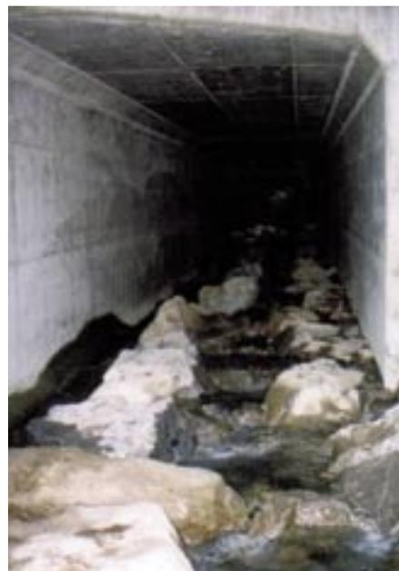
写真 - 16 動物の移動経路を確保したボックスカルバート
