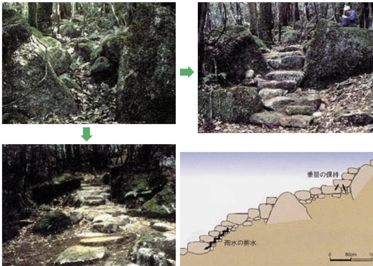
写真 - 12、図 - 10 地域固有の景観に配慮した散策道の事例(鹿児島県屋久島)
