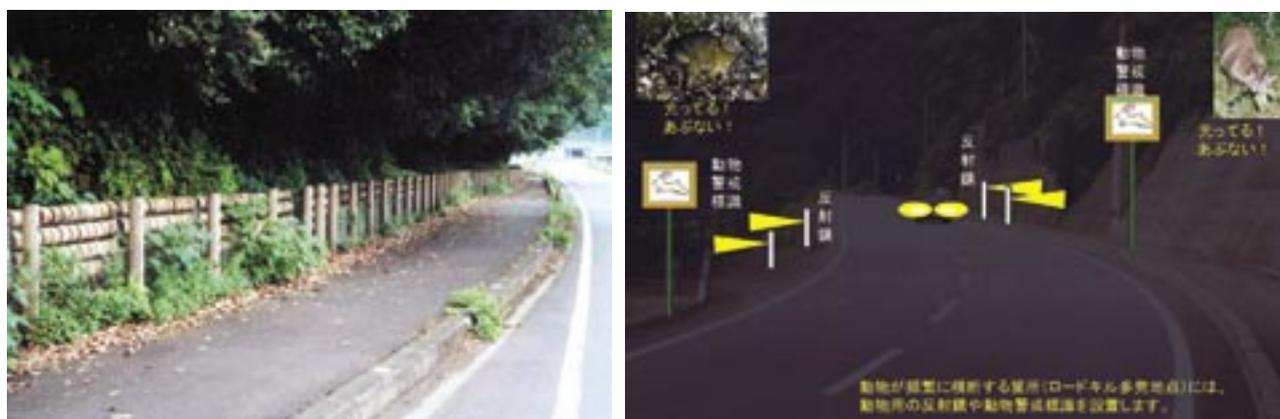
写真 - 7 ロードキル対策（動物誘導柵、反射板）の事例（西土佐村）
