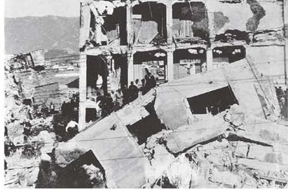
ビルの倒壊 高知市堺町付近
