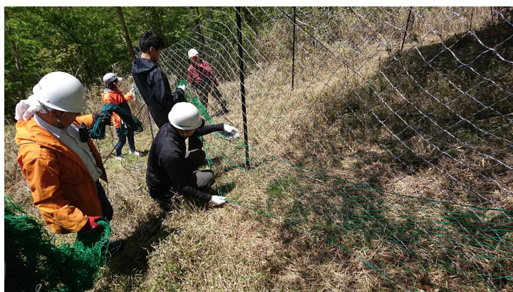
写真 1. 防鹿柵進入防止ネット張り作業
