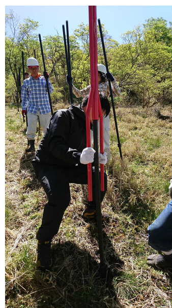
写真 2. 防鹿柵支柱の打ち込み作業
