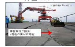
岸壁の沈下
