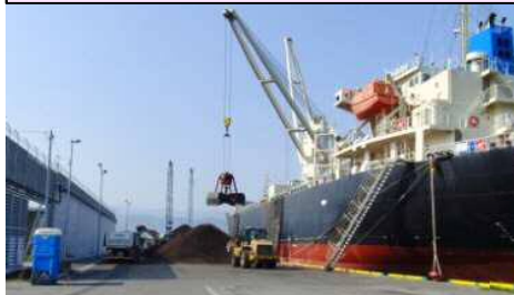
内貿の輸送拠点（PKS荷役状況）
