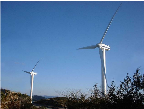
南喜ヶ峰風力発電所(香美市土佐山田町)
