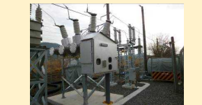
電気設備の更新
